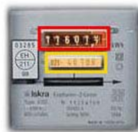
Einphasen Wechselstromzähler
